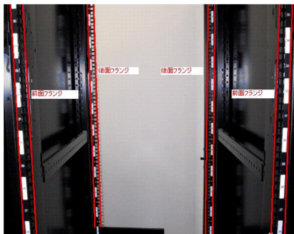
ラック上部から見た図 (サーバーをラックにマウントした状態)
